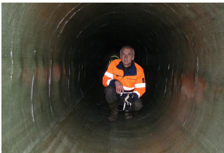
21.00 Avetablering. Kulverten åter i drift.
